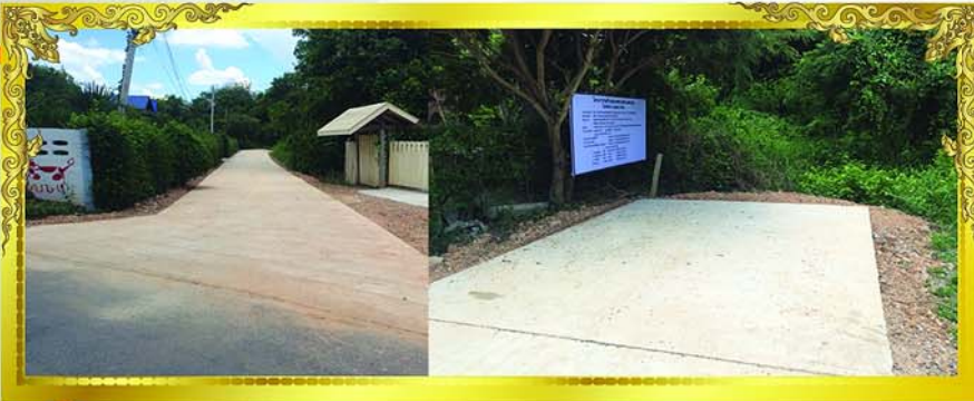
โครงการก่อสร้างถนน คสล. ถนนเทศบาล 7 ซอย 5 หมู่ 1
