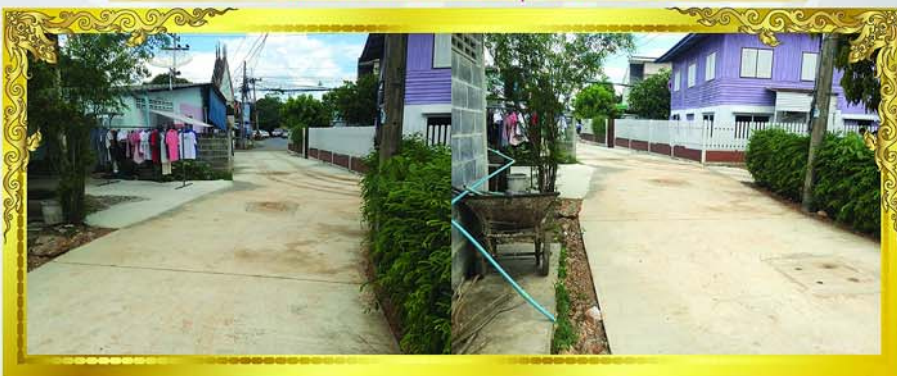
โครงการก่อสร้างถนน คสล. พร้อมวางท่อระบายน้ำ ถนนเทศบาล 1 ซอยคุ้มวัดบ้านกล้วย
