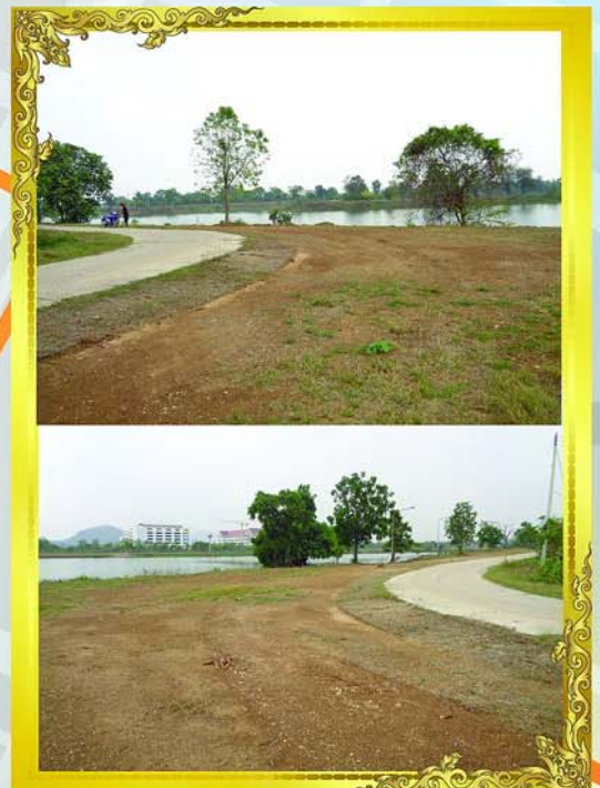
โครงการปรับปรุงทัศนคั่นอ่างเก็บน้ำชลประทาน คลองเพรียวหมู่ที่ 6
