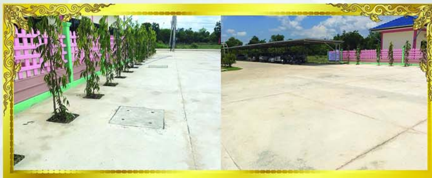
โครงการก่อสร้างลาน พร้อมวางท่อระบายน้ำ คสล. บริเวณหน้าอาคารสำนักงาน เทศบาลตำบลตะกุด
