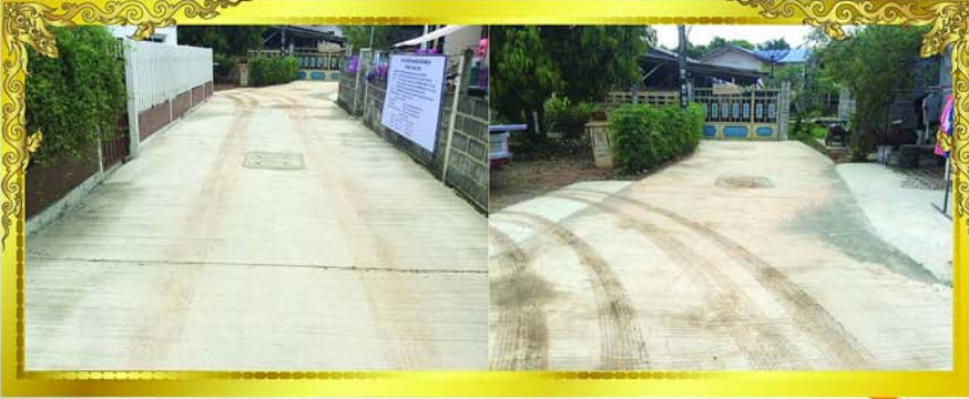
โครงการก่อสร้างถนน คสล. และวางท่อระบายน้ำ ถนนเทศบาล 1 ซอย 2 (ซอยดีดี)
