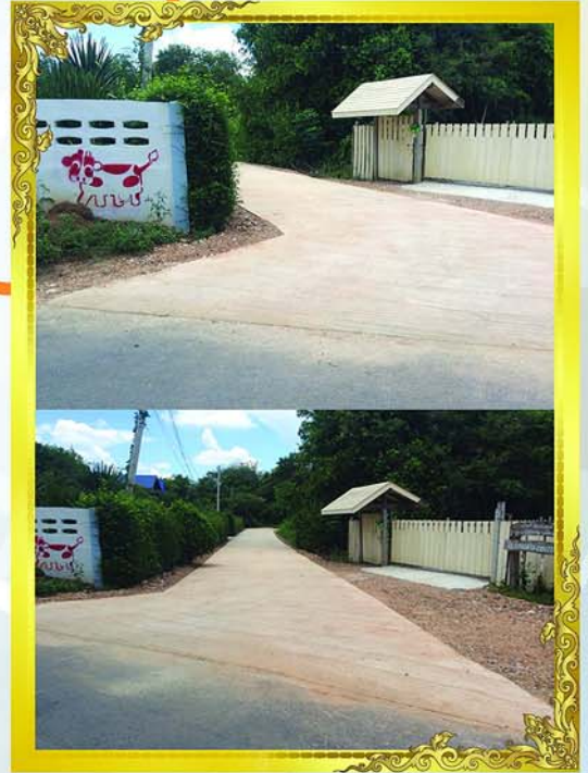
โครงการก่อสร้างถนน คสล. และวางท่อระบายน้ำ ถนนเทศบาล 7 ซอย 5 หมู่ 1
